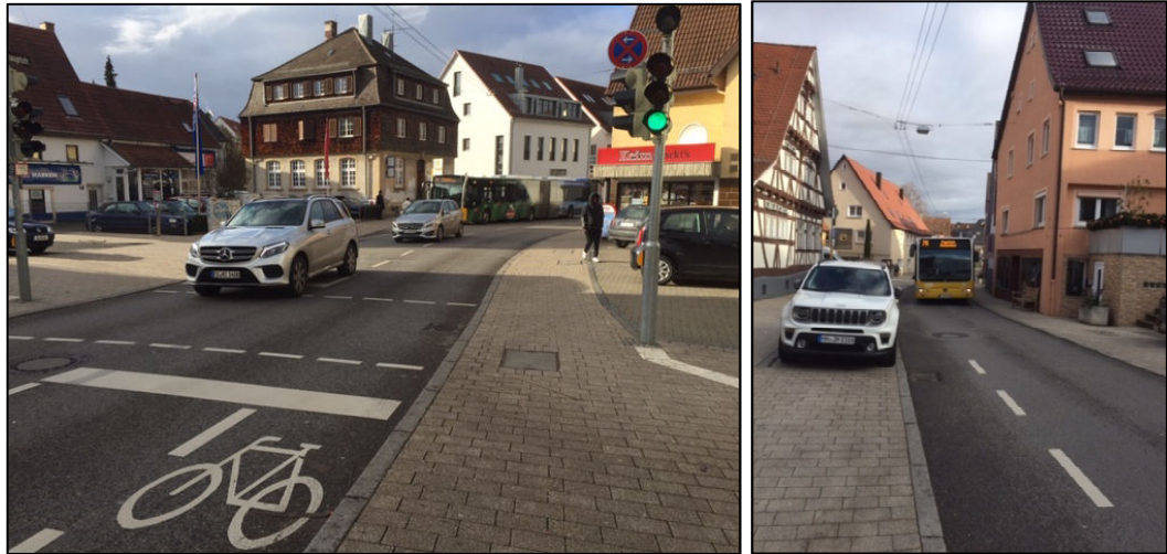
Abb. 22: ortskernsanierte Durchgangsstraßen: Filderhauptstraße mit intensiver Mischnutzung an der Unfallhäufungsstelle (links) Turnierstraße (Einbahnring) mit geringer Fahrbahnbreite von nur 3,50 m und hoher Lärmbelastung (rechts)
