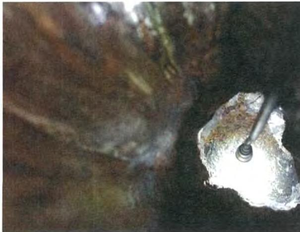
Bild 8 kleine schräge Höhlung, nach oben und unten fortgesetzt; kein Fledermauskot, Potenzial für Einzelquartier, nicht jedoch für WQ, nicht frostsicher
