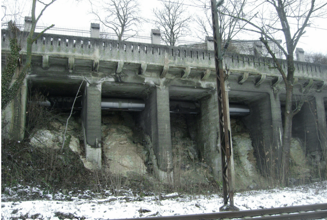
Bild 1: Galeriebauwerk am Michelsberg zur Überführung der Kienlesbergstraße über eine Erosionsrinne (unten im Bild: Gleis 405).
