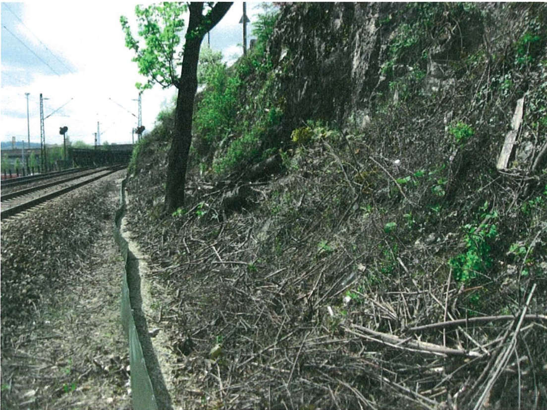
Abbildung 8: Maßnahmenfläche A 6 mit Reptilienzaun
