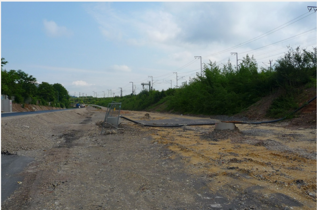
Abbildung 2: Gehölzbestände auf der Bahnböschung im Bereich der Haltestelle Mittnachtstraße
