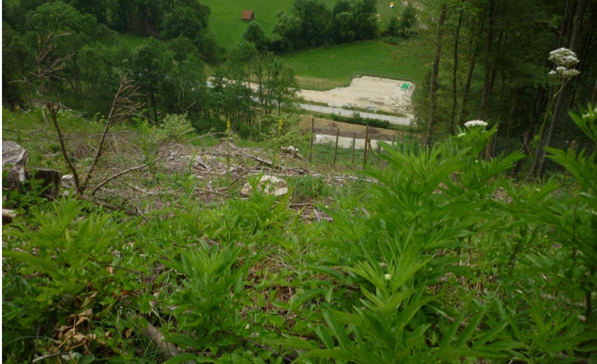
Blick nach Süden auf die Lichtung 0711A, die Baustellenflächen 0703A und 0708A.
