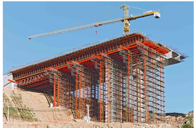
Herstellung des Überbaues mittels Traggerüst
