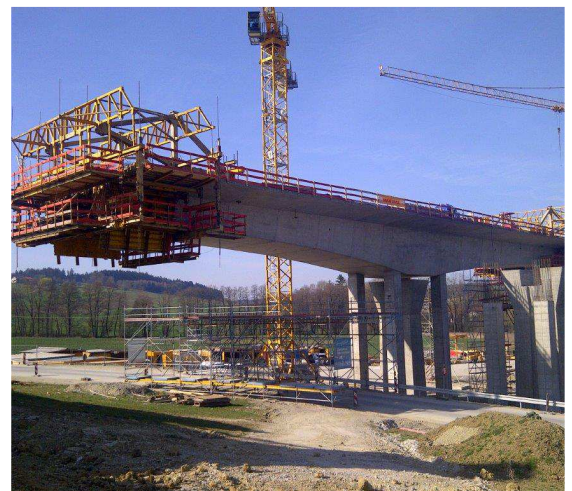
Herstellung des Überbaues mittels Freivorbau
