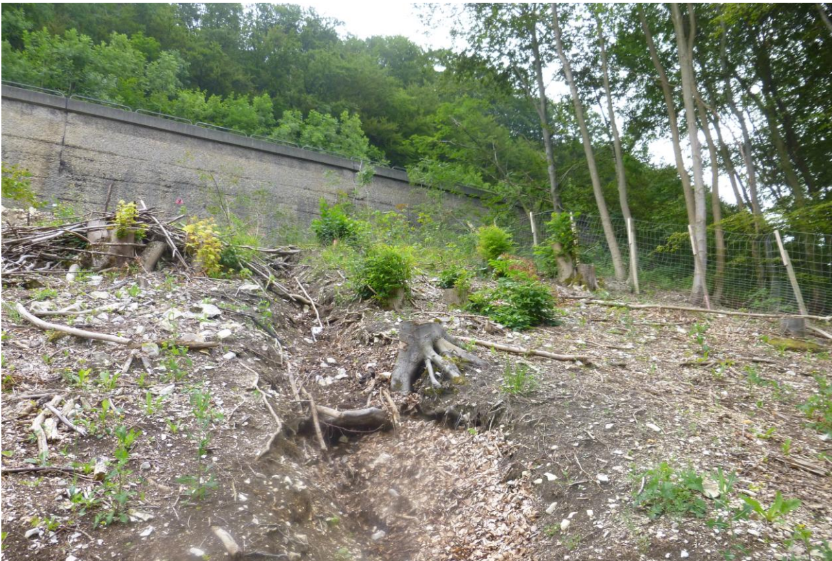
Blick nach Süden auf Lichtung 0752A, im Hintergrund Stützmauer der Autobahn
