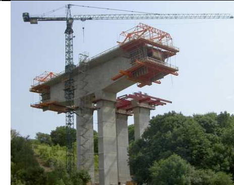
Herstellung des Überbaues mittels Freivorbau
