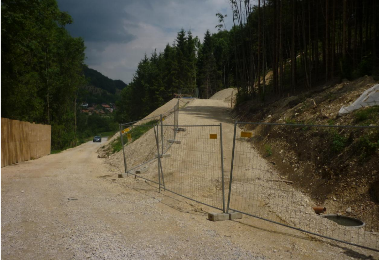
Blick nach Osten auf die Baustellenfläche 0751A
