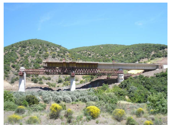
Herstellung des Überbaues mittels Vorschubrüstung
